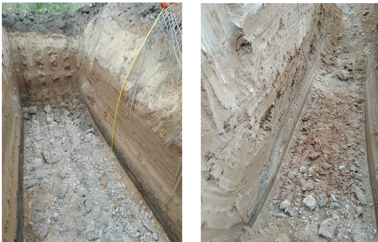
Рисунок 37 — Места проходки шурфов в песчаном и рабочем слое дорожной конструкции
