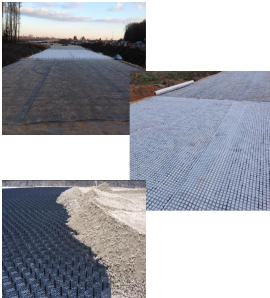
Рисунок 2 — Виды материалов, уложенных на опытно-экспериментальном полигоне
